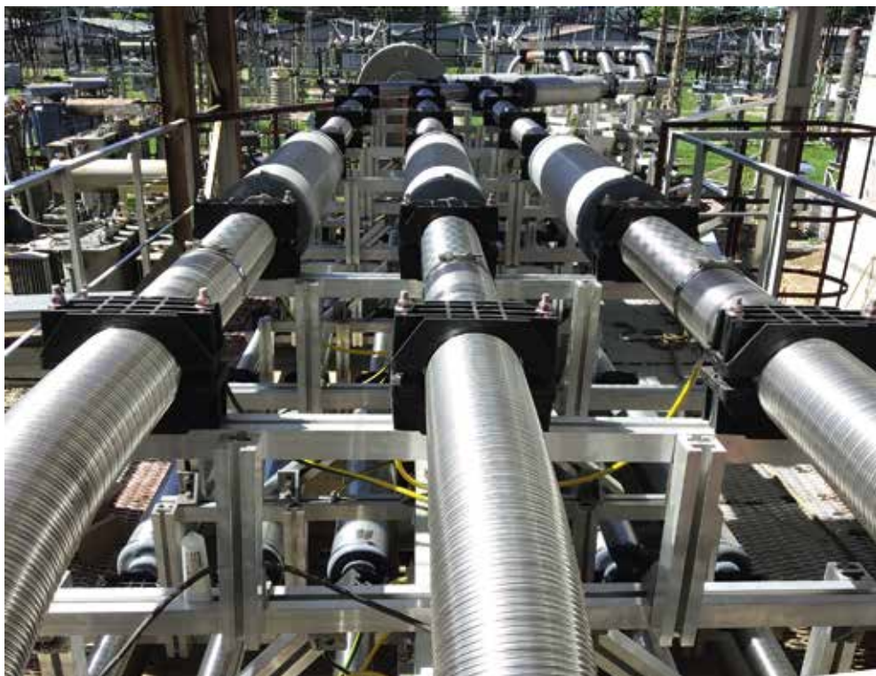
ТЭЦ-20 ПАО «Мосэнерго». Токопровод ТПЛА-6-2000 УХЛ1
